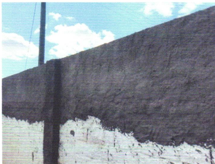
FOTO 07 - EMBOÇO OU MASSA ÚNICA EM ARGAMASSA INDUSTRIALIZADA, PREPARO MECÂNICA E APLICAÇÃO COM EQUIPAMENTO DE MISTURA E PROJEÇÃO DE 1,5 M3/H DE ARGAMASSA EM PANOS DE FACHADA COM PRESENÇA DE VÃOS, ESPESSURA DE 25 MM, ACESSO POR ANDAIME. AF_08/2022
