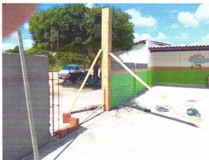
FOTO 08 - CONCRETAGEM DE PILARES, FCK = 25 MPA, COM USO DE BALDES - LANÇAMENTO, ADENSAMENTO E ACABAMENTO. AF_02/2022
